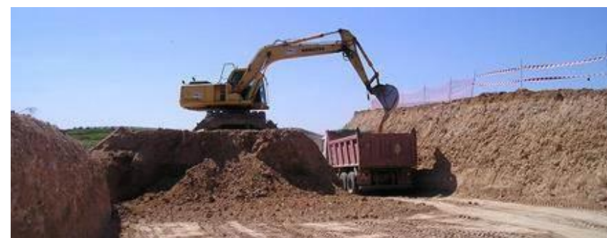
Ilustración 29 - Movimiento de Tierra
