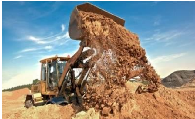
Ilustración 30 - Movimiento de Tierra
